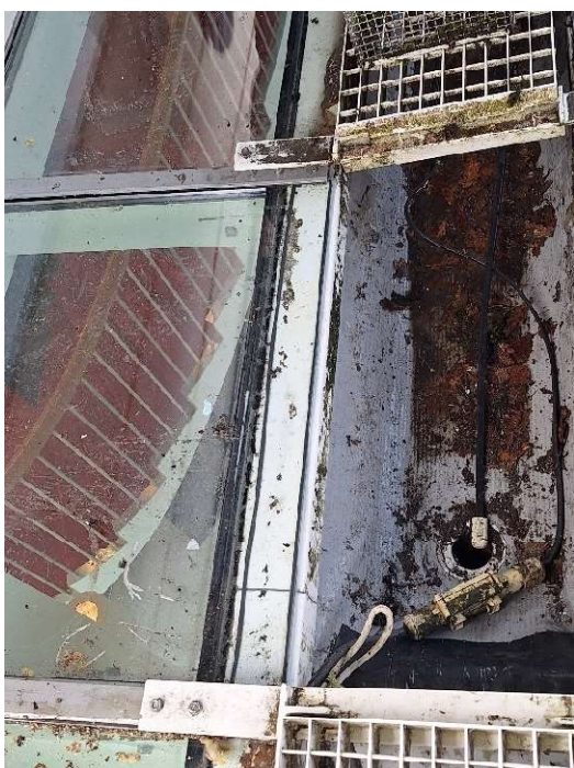
Abb. 49: grobverschmutzte Wasserrinne
