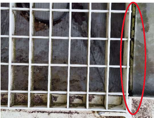
Abb. 102: verschmutzte Fugen unter dem Glas
