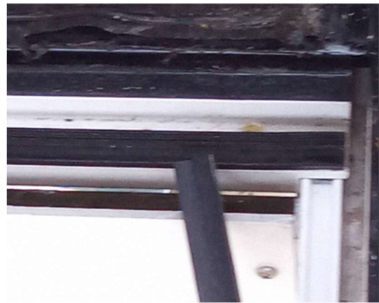
Abb. 122: Beispiel nicht verklebter Dichtungsstöße
