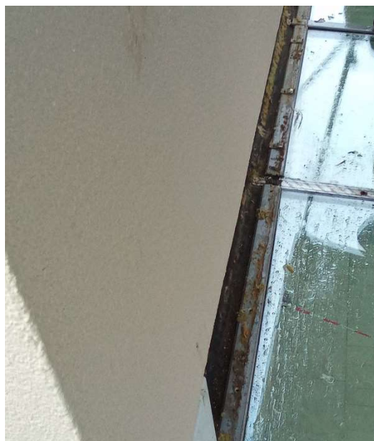
Abb. 66: Wandanschluss Sockelblech entfernt
