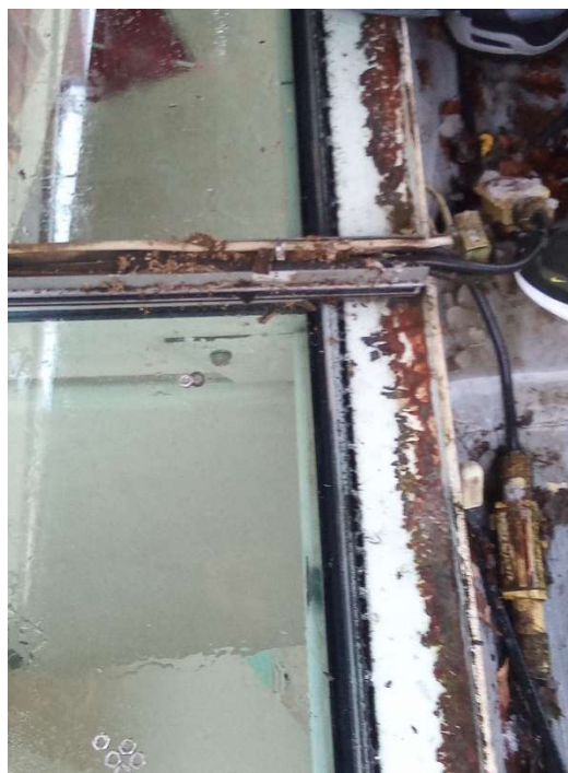
Abb. 58: Kabelkanal, sehr verschmutzt
