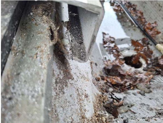
Abb. 39: hohe Verschmutzung unterhalb des Bleches
