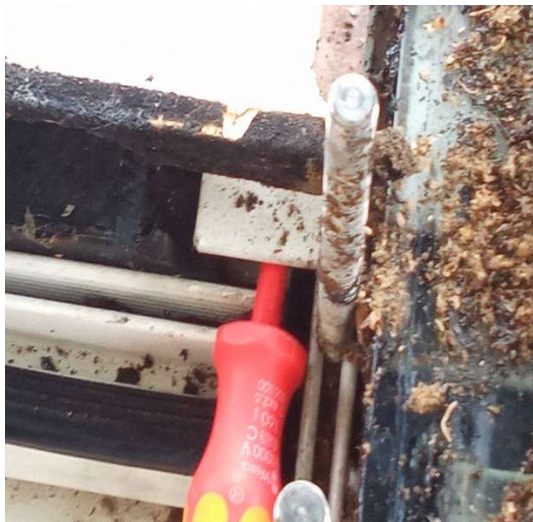
Abb. 85: offene Stelle an Unterkante Glasdach
