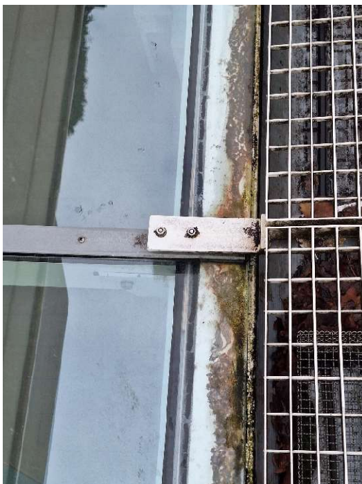
Abb. 9: deutlich defekte Versiegelung an Glaskante
