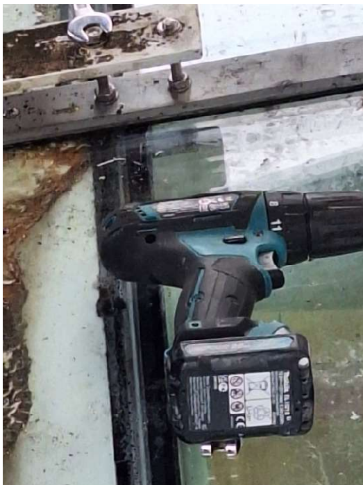
Abb. 47: Befestigung der Gitterroste
