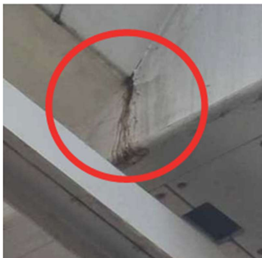
Abb. 18: Detailaufnahme Wasserspuren 2023
