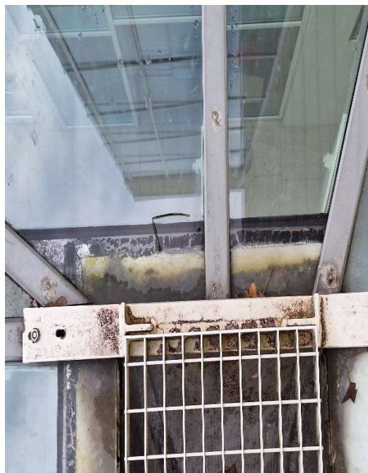
Abb. 101: hohe Verschmutzung unter dem Glas
