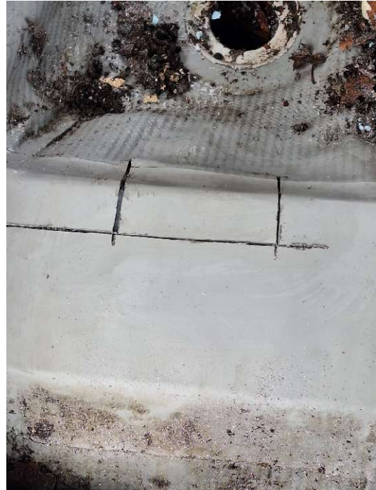
Abb. 42: Schnittfeld in der Wasserrinne
