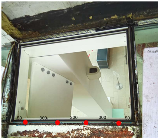
Abb. 123: SOLL-Befestigung unten horizontal
