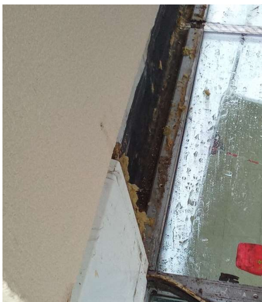
Abb. 65: Öffnung des Wandanschlusses
