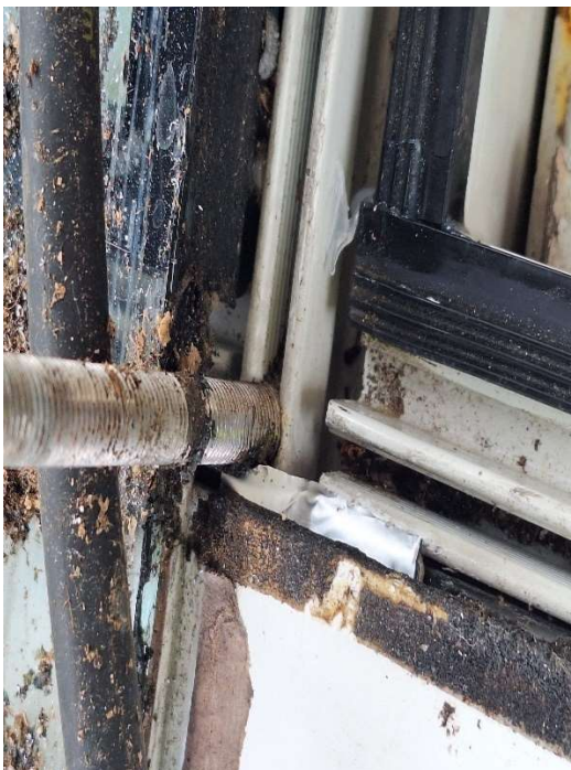
Abb. 41: Schraubendurchdringung im Dachsparren
