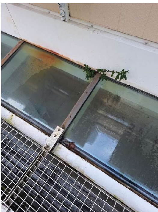
Abb. 11: Pflanzenwuchs in Fugen
