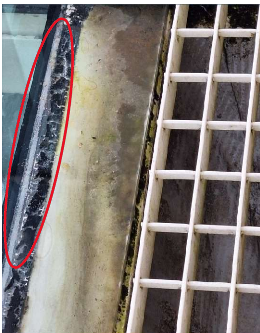
Abb. 100: offener „Luftspalt“; offene Fugen am Glas
