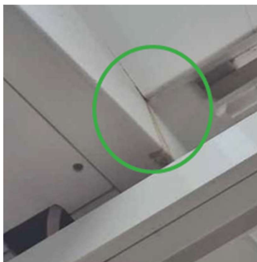
Abb. 30: Wasser- und Rostspuren 2023
