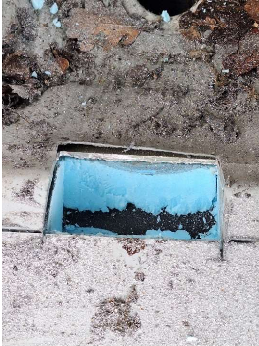
Abb. 43: aufgeschnittene Wasserrinne
