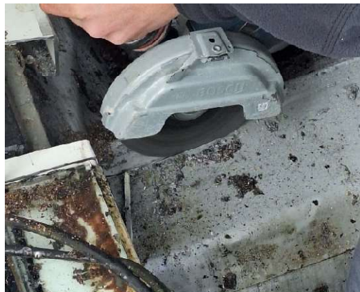
Abb. 38: Flexarbeit am weißen Kantblech
