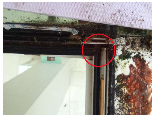
Abb. 76: offene Dichtungsstöße
