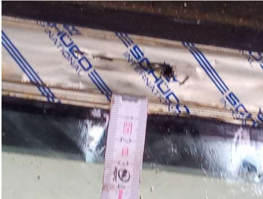
Abb. 71: Überdeckung Butylband auf Glas
