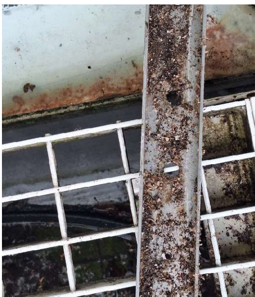
Abb. 45: starke Verschmutzung Unterseite Abdeckprofil
