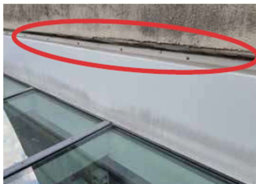
Abb. 111: Anschluss Blech zu Wand (Quelle: K+S Architekten) Abb. 112: wie vor, andere Stelle Quelle: K+S Architekten)
