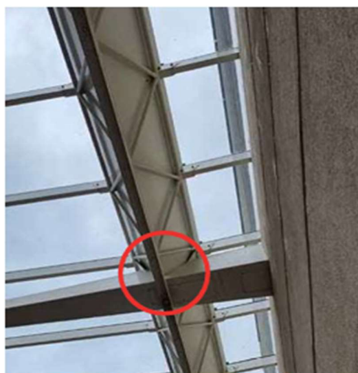
Abb. 17: Wasserspuren
