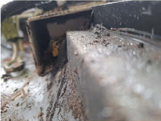
Abb. 35: weißes Abschlussblech zur Rinne geöffnet
