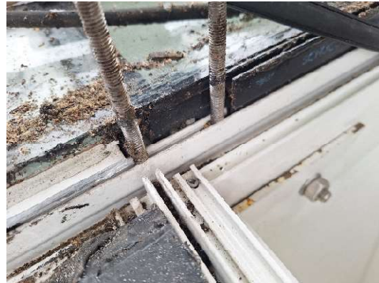
Abb. 40: Schraubendurchdringung im Dachsparren
