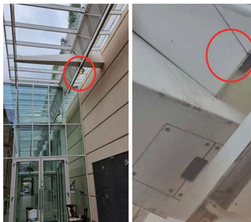
Abb. 24: Detailaufnahme Wassereintritt 2023
