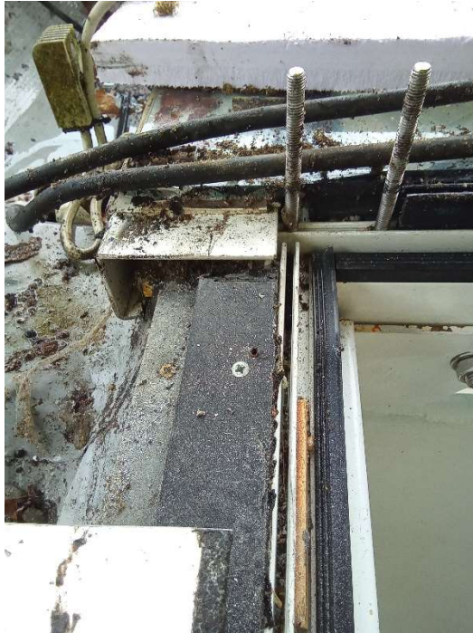
Abb. 89: unterer Dachanschluss an Rinne
