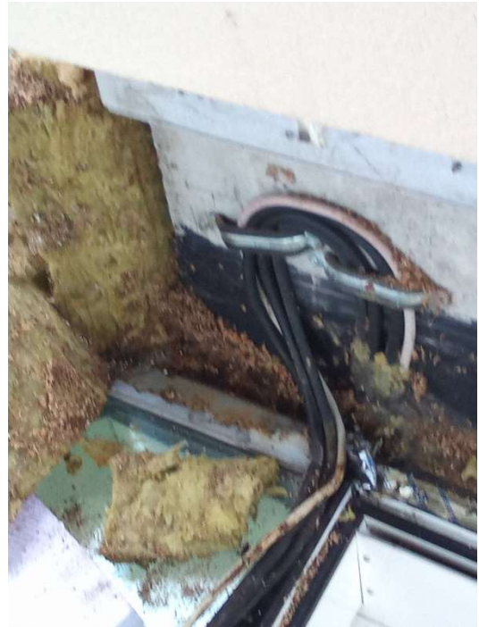
Abb. 78: Kabelführung u. Durchdringung Baukörper
