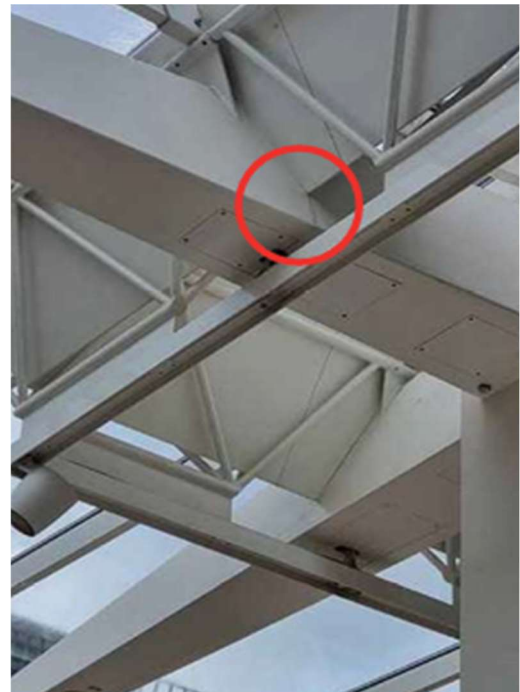
Abb. 33: undichte Stelle
