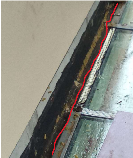
Abb. 67: Wassereintrittsmöglichkeit
