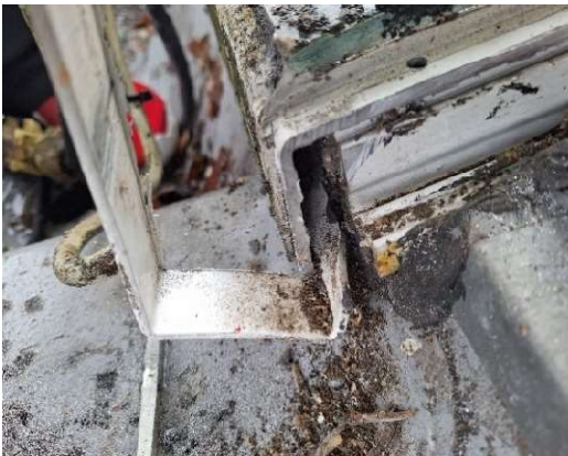
Abb. 37: Pfostenentwässerung funktioniert
