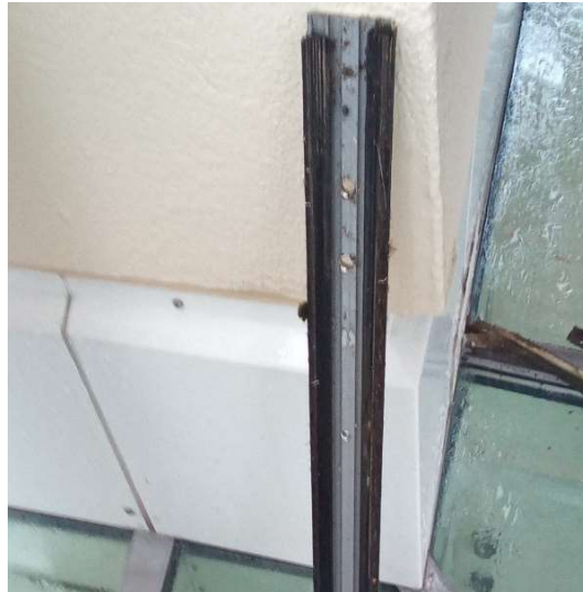
Abb. 60: Pressleiste mit Außenglasdichtung
