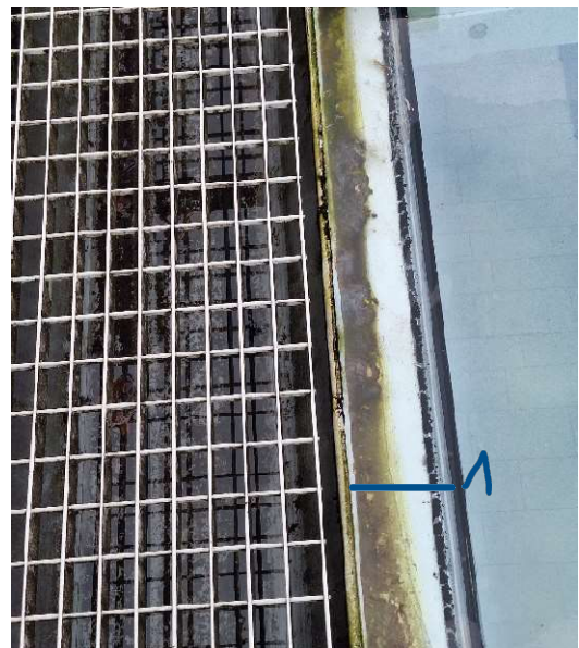
Abb. 8: überstehendes Glas und darunter Schmutz
