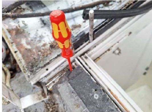
Abb. 36: undichte Stelle
