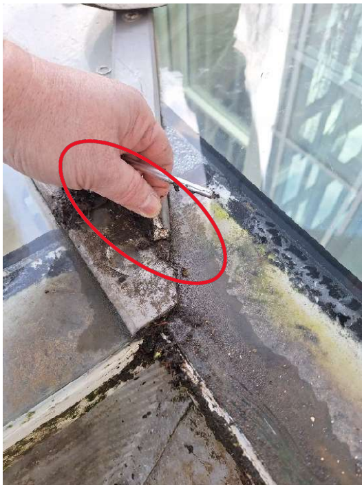
Abb. 106: Überprüfung Fugenabdichtung
