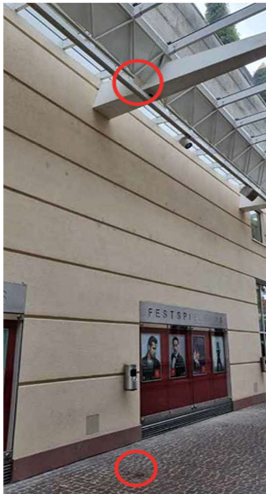
Abb. 15: Wasserflecken unterhalb des Daches
