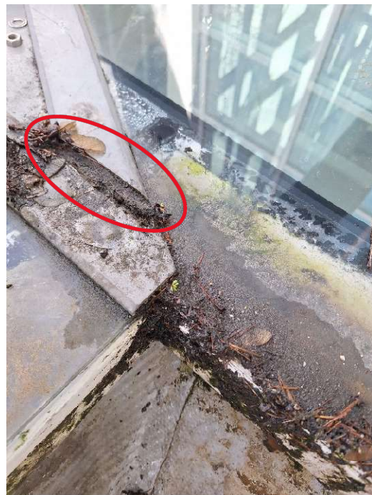
Abb. 107: Ergebnis defekt und offen, nachversiegelt
