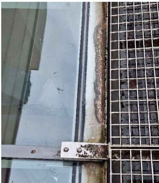
Abb. 7: Glasüberstand aufliegend auf weißem Blech
