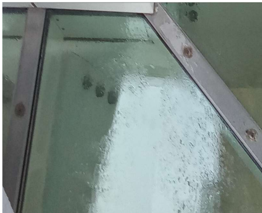
Abb. 121: zugesiegelte Schraubenköpfe an vielen Stellen
