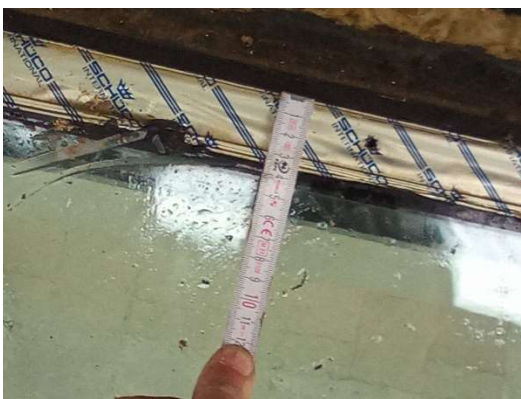
Abb. 69: Zustand des Butylbands während Demontage
