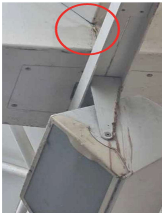
Abb. 22: Wasserspuren
