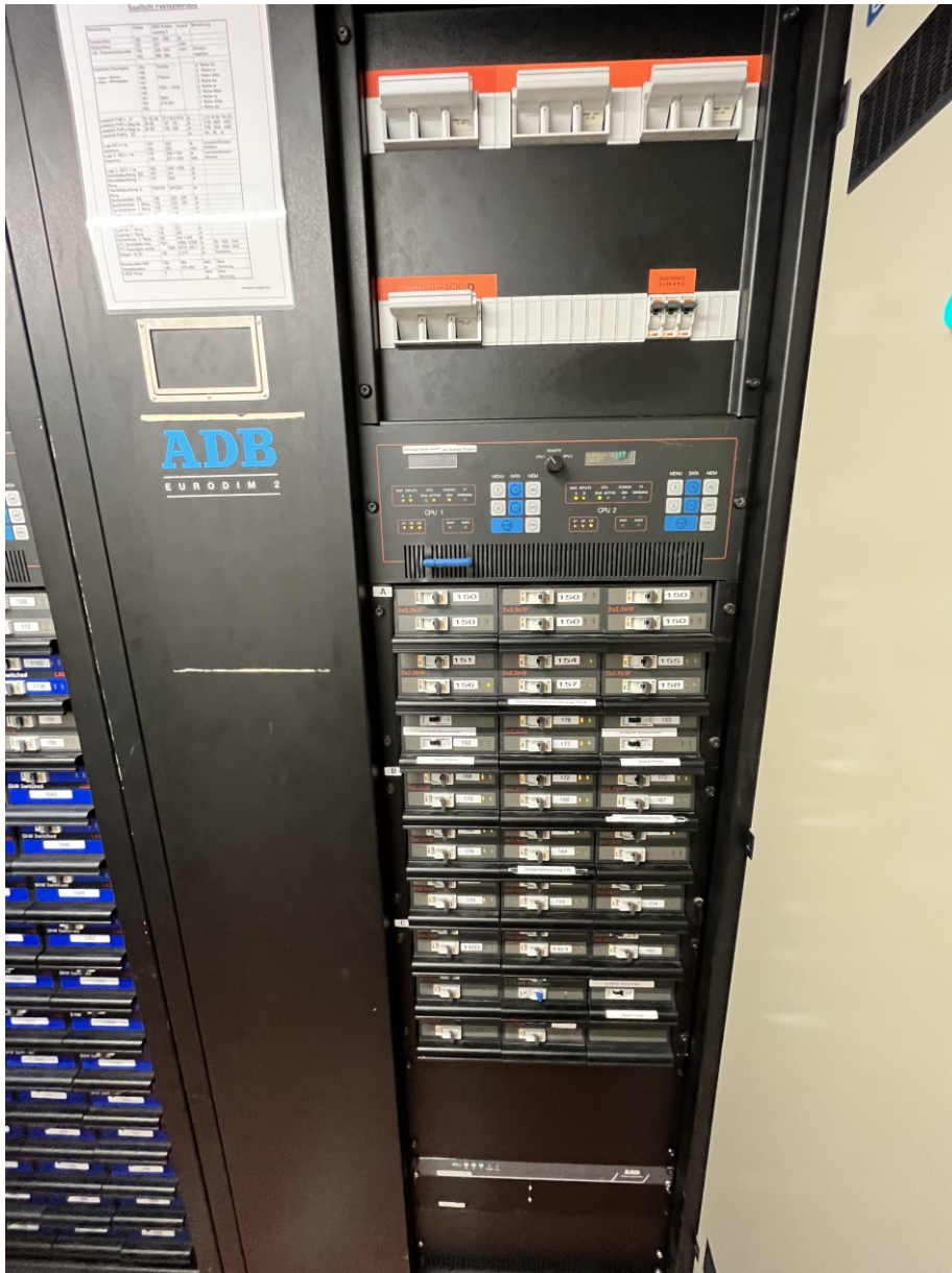
Technikschrank 19" mit Dimmer-Einheiten
